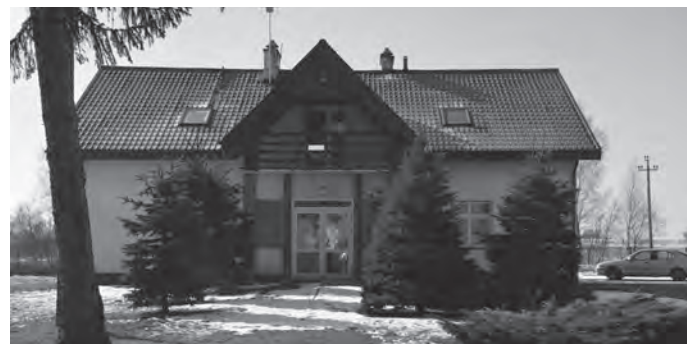
Fot.: Budynek w Wesolówce, w którym ruszą prace remontowe związane z utworzeniem żłobka.
